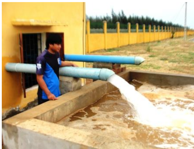
Trạm bơm ly tâm hút xa HS150-11, H = 15 m, Q = 150 m 3 /h, N = 11 kW
