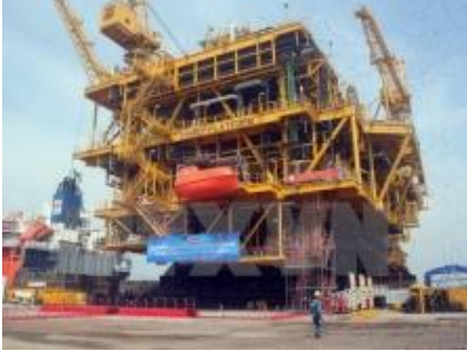
Giàn công nghệ HRD đã được hạ thủy thành công tại Cảng hạ lưu PTSC, TP Vũng Tàu(Ảnh Internet)
