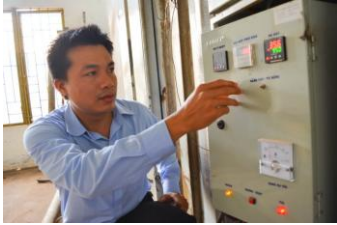
Anh Nguyễn Minh Vũ kiểm tra chiếc tủ điều khiển lò sấy máy biến áp - Ảnh: L.Hồng
